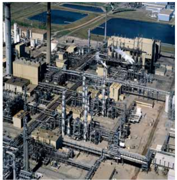
Рисунок ТР.4. (a) Улавливание CO 2 после сжигания топлива на установке в Малайзии. В этой установке применяется процесс химической абсорбции для отделения 0,2 МтCO 2 в год от потока дымового газа энергоустановки для производства мочевины, работающей на сжигании газа (с разрешения «Мицубиси хэви индастриз»); (b) улавливание CO 2 до сжигания на установке газификации угля в Северной Дакоте, США. В этой установке применяется процесс на основе физического растворителя для отделения 3,3 МтCO 2 в год из газового потока для производства синтетического природного газа. Часть захваченного CO 2 используется для проекта ПИН в Канаде.
