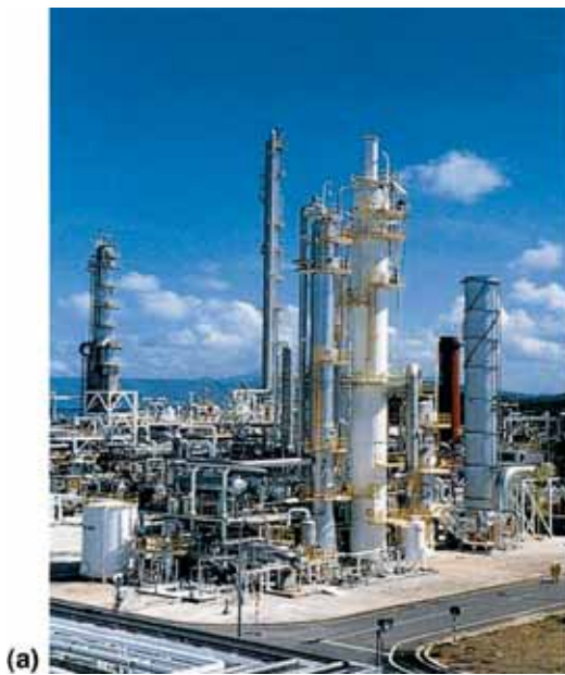
Рисунок ТР.4. (a) Улавливание CO 2 после сжигания топлива на установке в Малайзии. В этой установке применяется процесс химической абсорбции для отделения 0,2 МтCO 2 в год от потока дымового газа энергоустановки для производства мочевины, работающей на сжигании газа (с разрешения «Мицубиси хэви индастриз»); (b) улавливание CO 2 до сжигания на установке газификации угля в Северной Дакоте, США. В этой установке применяется процесс на основе физического растворителя для отделения 3,3 МтCO 2 в год из газового потока для производства синтетического природного газа. Часть захваченного CO 2 используется для проекта ПИН в Канаде.
